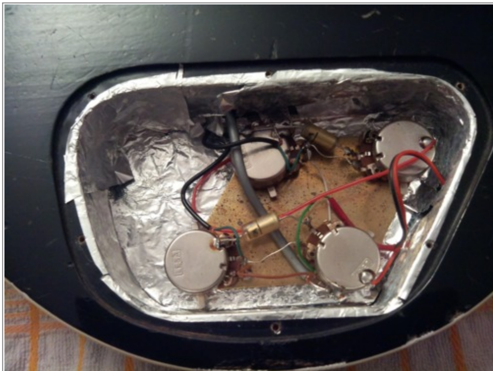
Les condensateurs originaux encore en place.
